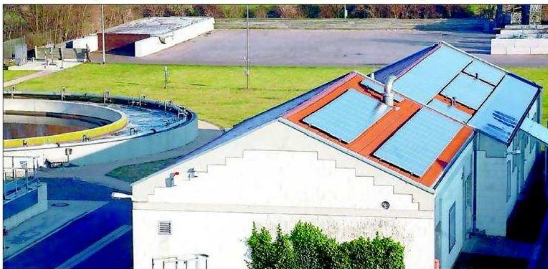
Die Stadtwerke Deidesheim haben bereits Ende 2007 eine Solaranlage zur Stromerzeugung auf drei Dächern der Kläranlage in Niederkirchen in Betrieb genommen. Der jährlichen Stromertrag entspricht in etwa dem Strombedarf von 26 Haushalten.
